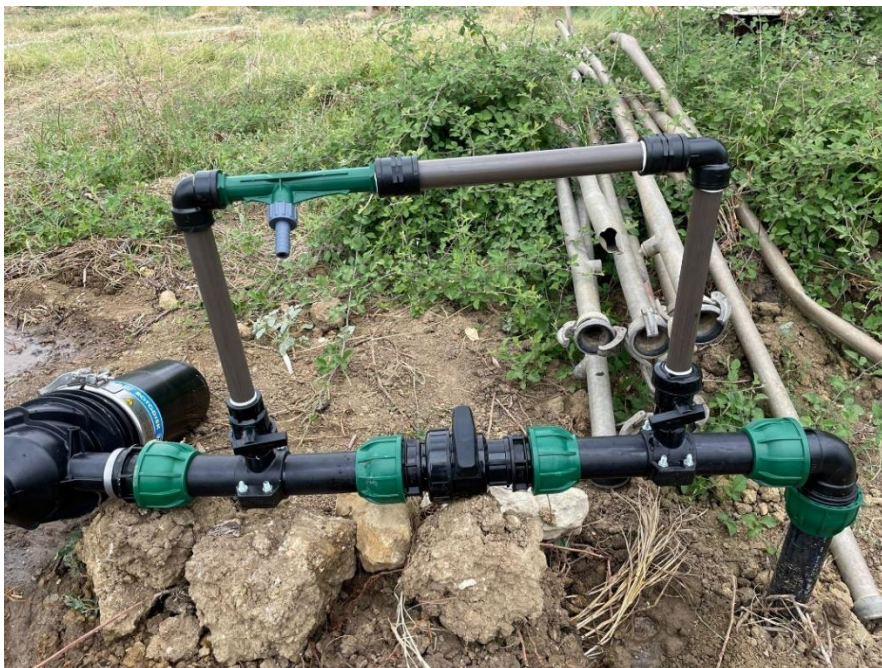
Slika 1.4 Primjer uređaja za prihranu putem Venturi cijevi; Izvor: Projekt sustava navodnjavanja za plantažu maslina i povrtnih kultura koji uključuje parcele sa ARKOD ID: 464202, 736920, 3471855, 736899, 737001, 737123. Glavni projekt – građevinsko-tehnološki.
