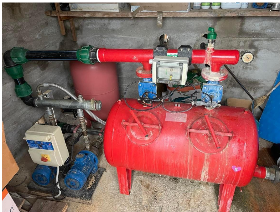
Slika 1.3 Primjer pješčane filterske stanice; Izvor: Projekt sustava navodnjavanja za plantažu maslina i povrtnih kultura koji uključuje parcele sa ARKOD ID: 464202, 736920, 3471855, 736899, 737001, 737123. Glavni projekt – građevinsko-tehnološki.
